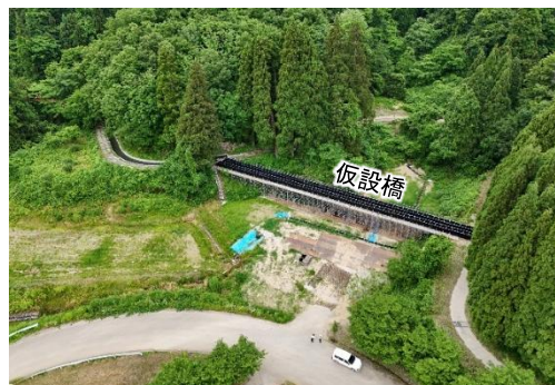
写真.4 用水路の仮設橋の設置状況
