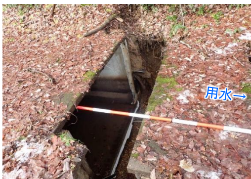
① 用水路の破断 (70cm 程度)
