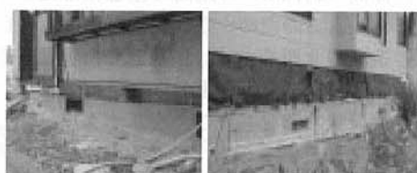
写真-6 沈下修正工事の状況
