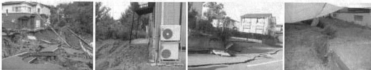
写真-2 宅地の被害(左より谷埋め盛土の崩壊, 崩壊した宅地, 外周道路縁部の亀裂・段差, 宅地内の亀裂・段差)
