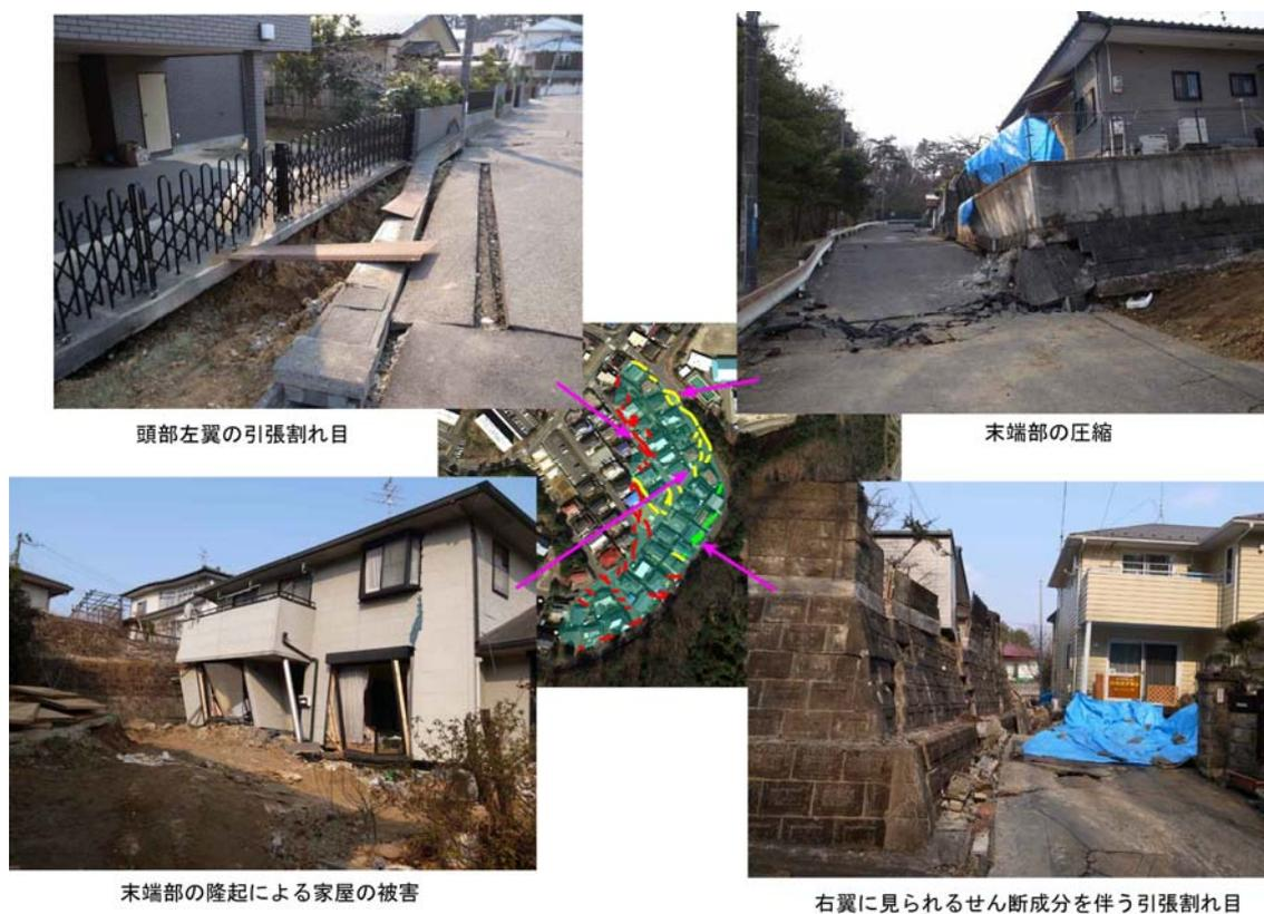
図-4 折立 5 丁目地すべりの被災状況
