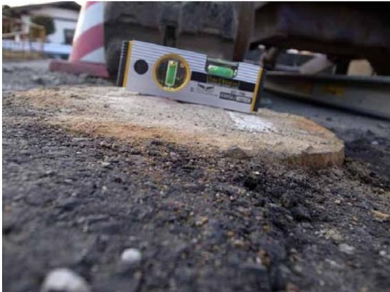
写真-3 鋼管杭頭。約  $10^\circ$  傾斜している
