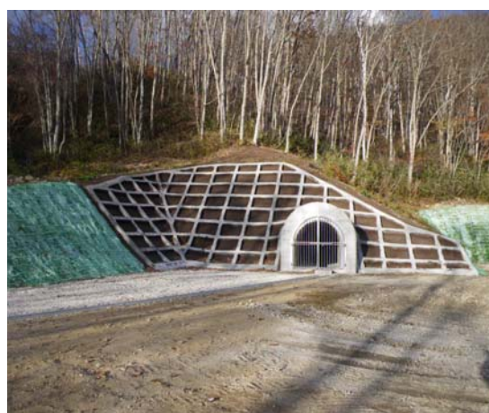
写真2 排水トンネル坑口部全景
