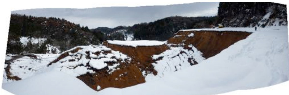
写真.1 地すべり頭部の状況
